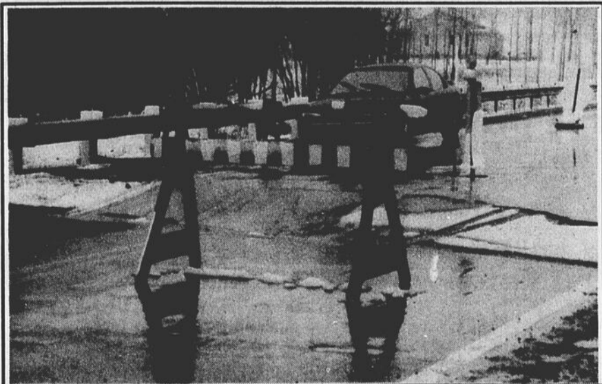
Les travaux de remplacement du ponceau affaissé sur la route 138 débuteront dès que les conditions du terrain le permettront.
