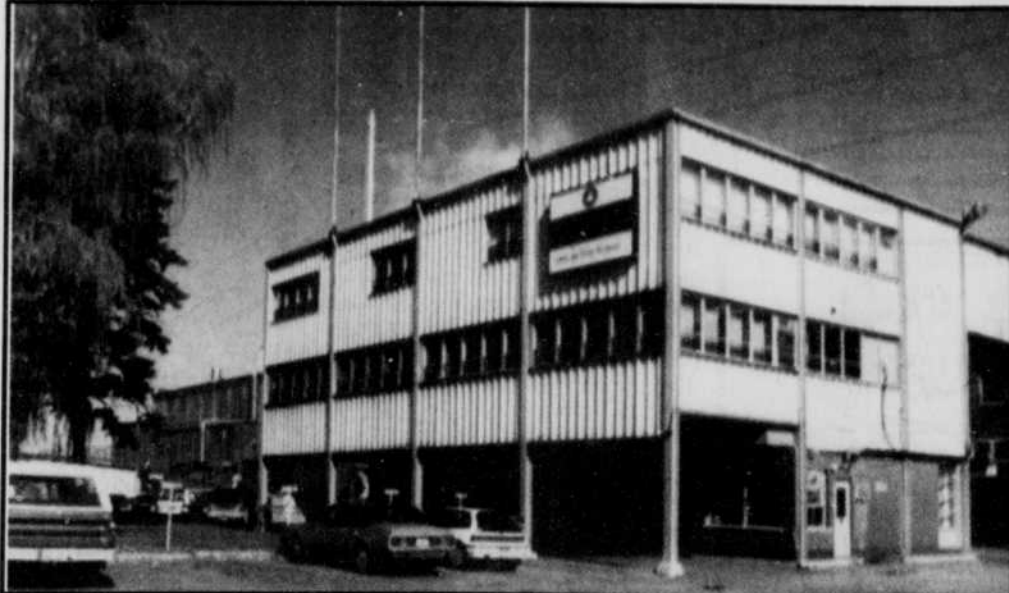
L'usine PFCP de Trois-Rivières.
