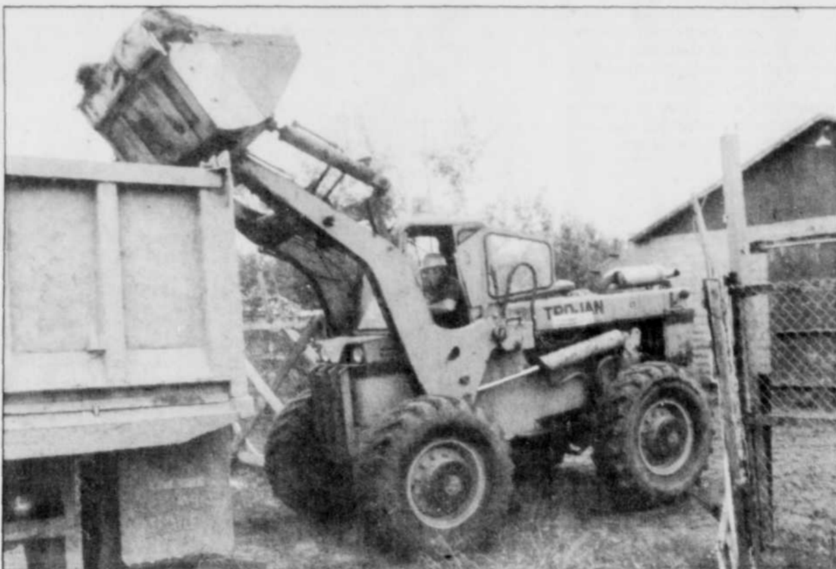
Tout le terrain entourant l'entrepôt de BPC de Shawinigan-Sud a été nettoyé, à l'aide d'une chargeuse mécanique. Tous les déchets et débris de bois ont été chargés dans un camion et transportés dans un dépôt de déchets secs de la ville de Shawinigan-Sud.
