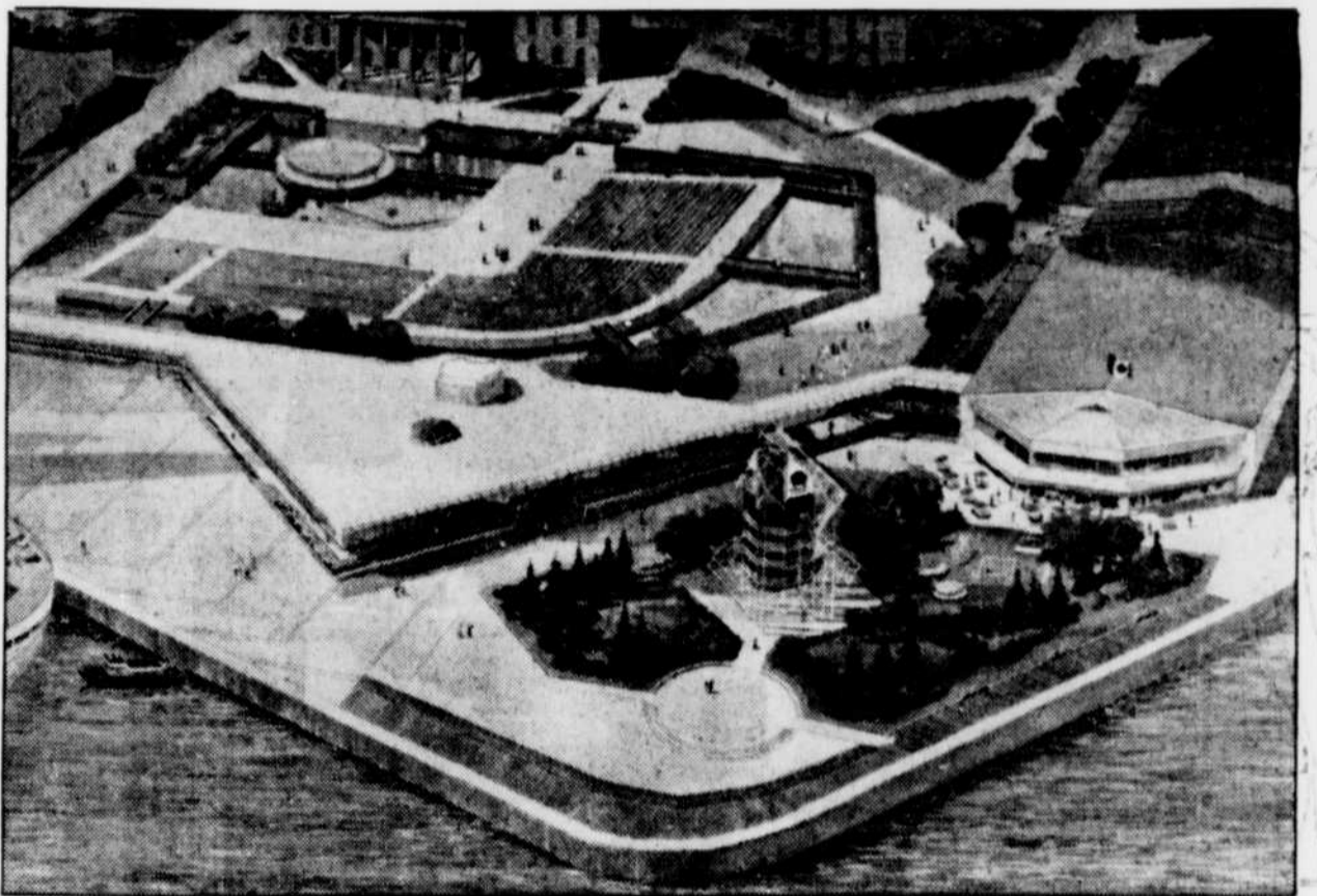
L'Agora, la tour d'observation et le hangar des boutiques.
