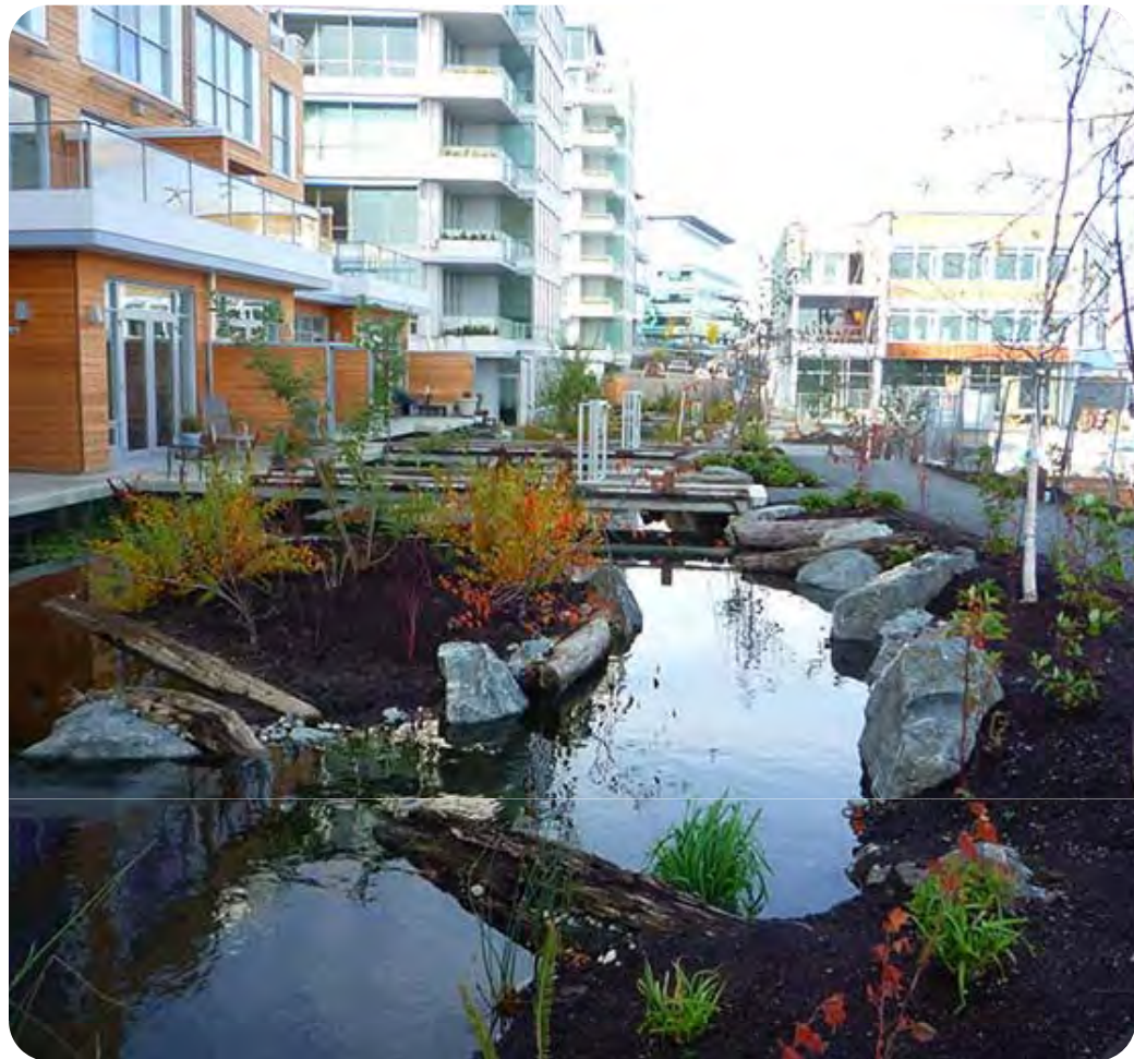
Système de marais filtrants
