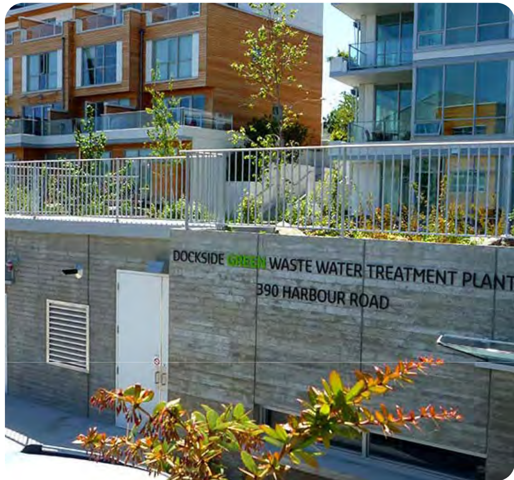
Système centralisé de traitement des eaux noires
