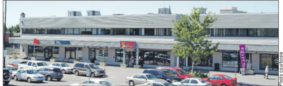
Vue de la façade de Plaza Laval, avant les rénovations.
