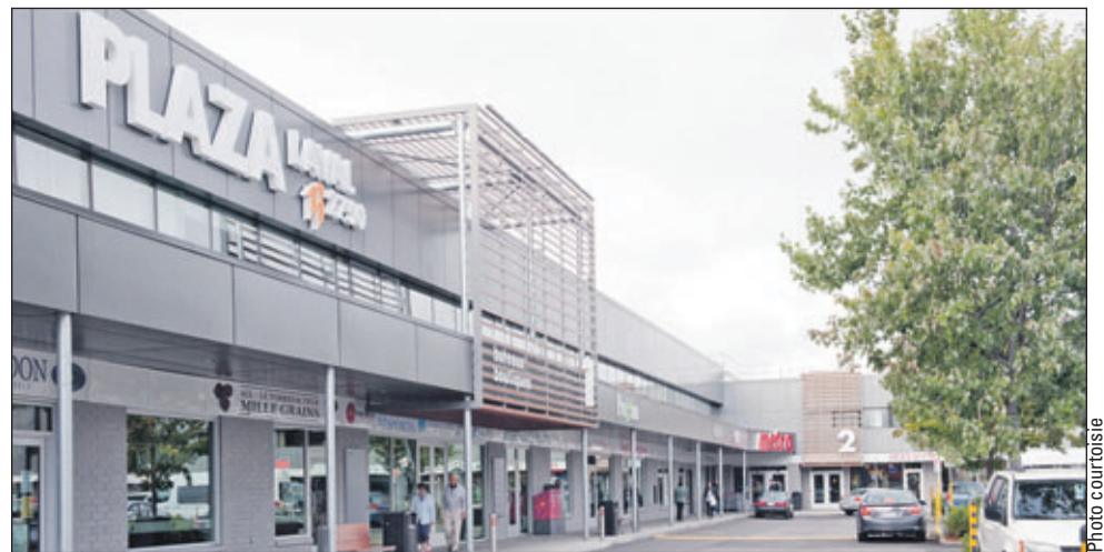
Vue de la façade, une fois les rénovations complétées
