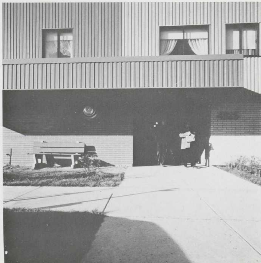
L'entrée principale protégée par la marquise avec le mur en brique émaillée
