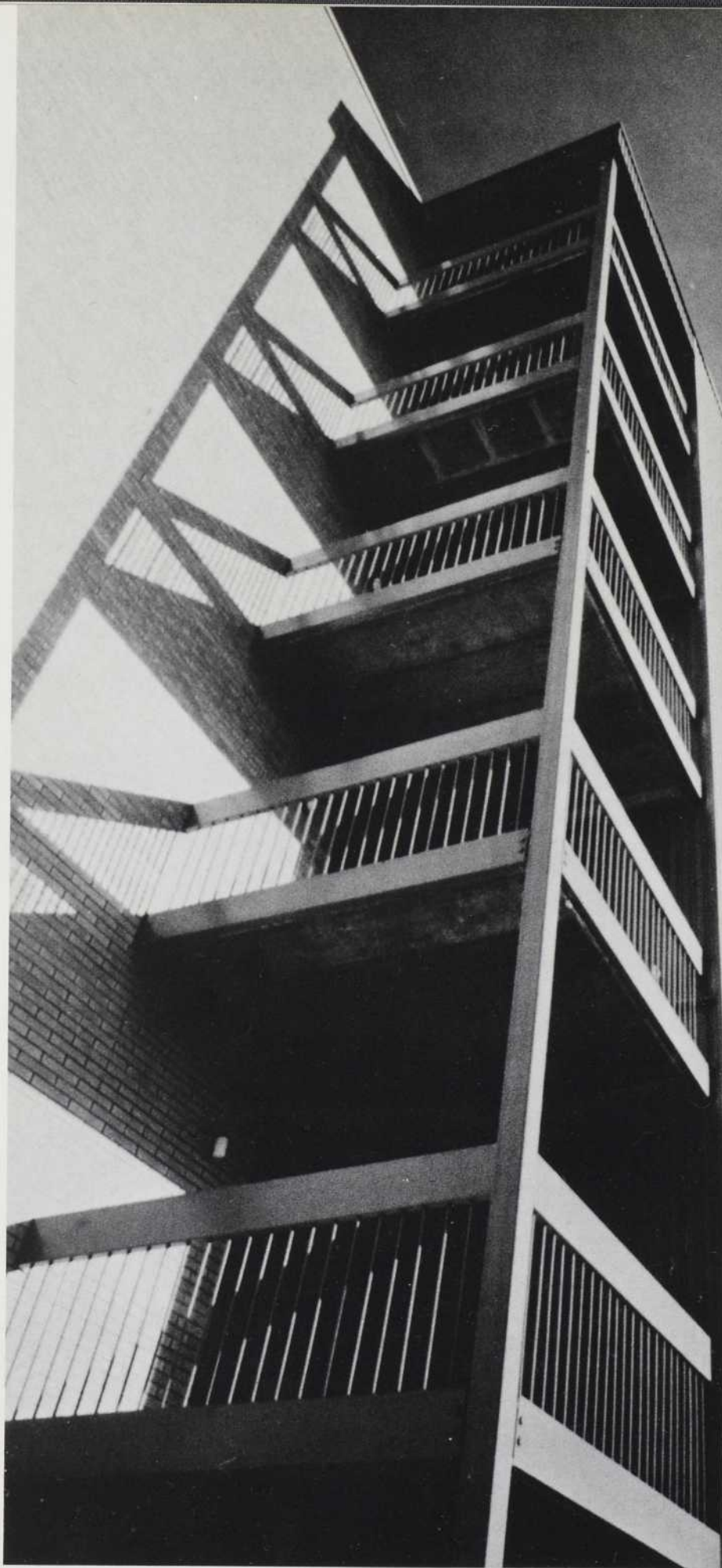
Vue des balcons communautaires aux étages
