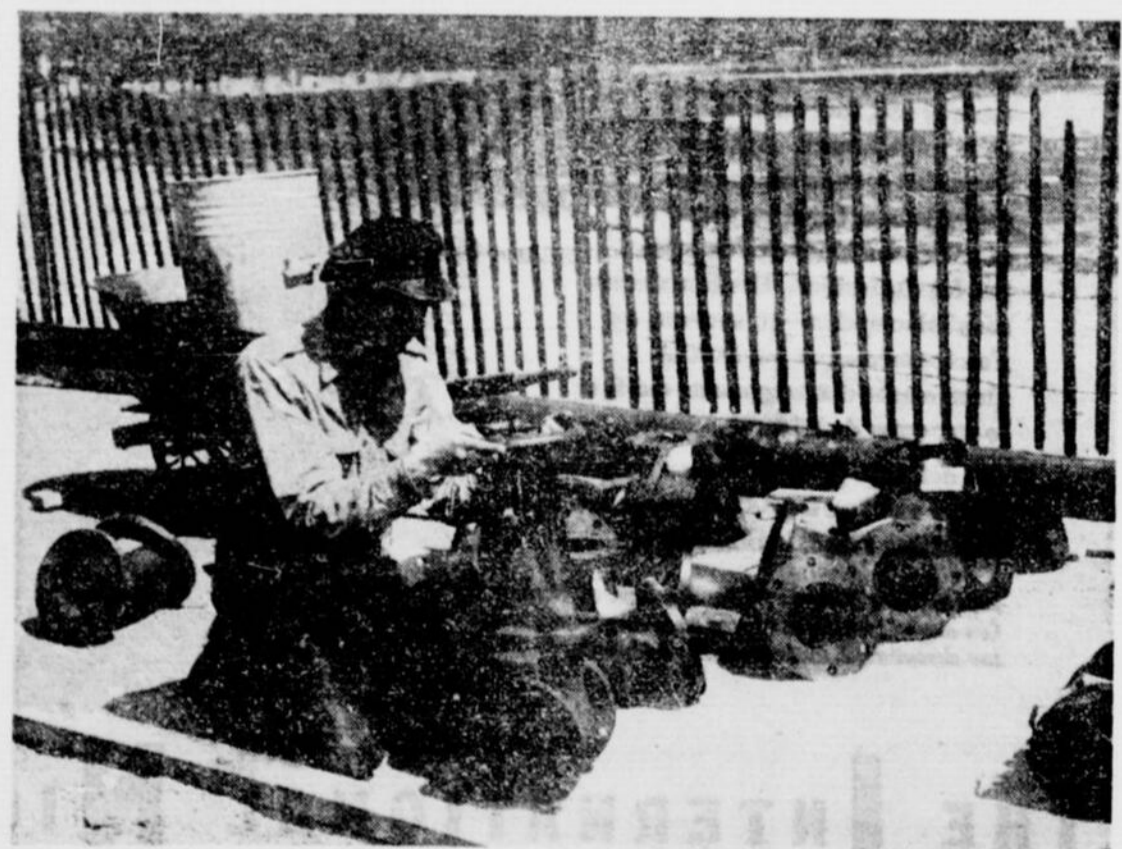
PAR UNE CHALEUR D'ÉTÉ, ce travailleur s'affaire à installer la tuyauterie de la première patinoire à ciel ouvert avec glace artificielle dont sera doté Montréal et que l'on se propose d'inaugurer d'ici quelques semaines.
