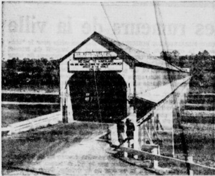
LE PONT COUVERT qui enjambe la rivière St-Jean à Hartland, au Nouveau-Brunswick, et qui mesure 1.282 pieds de longueur, est le plus long en son genre au monde. Construit en 1920, ce pont est une des curiosités recherchées des touristes qui se plaisent à le photographier.
