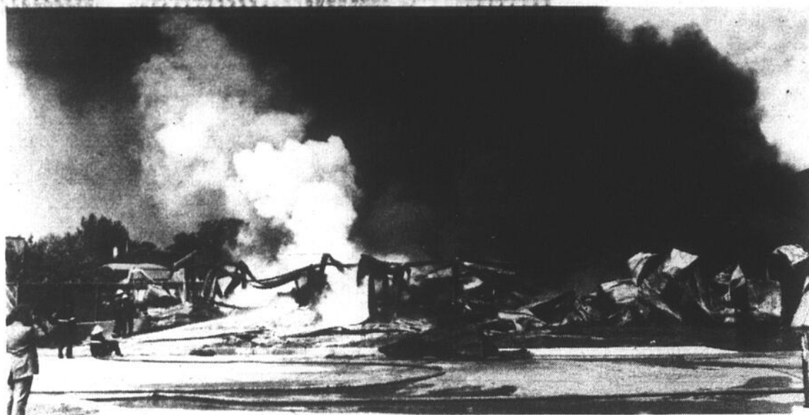
La fumée qui s'échappait de l'entrepôt était telle, qu'elle pouvait facilement être vue par les citoyens de Montréal. Les pompiers de Laval et Ste-Rose ont travaillé de longues heures avant de maîtriser le violent incendie.
