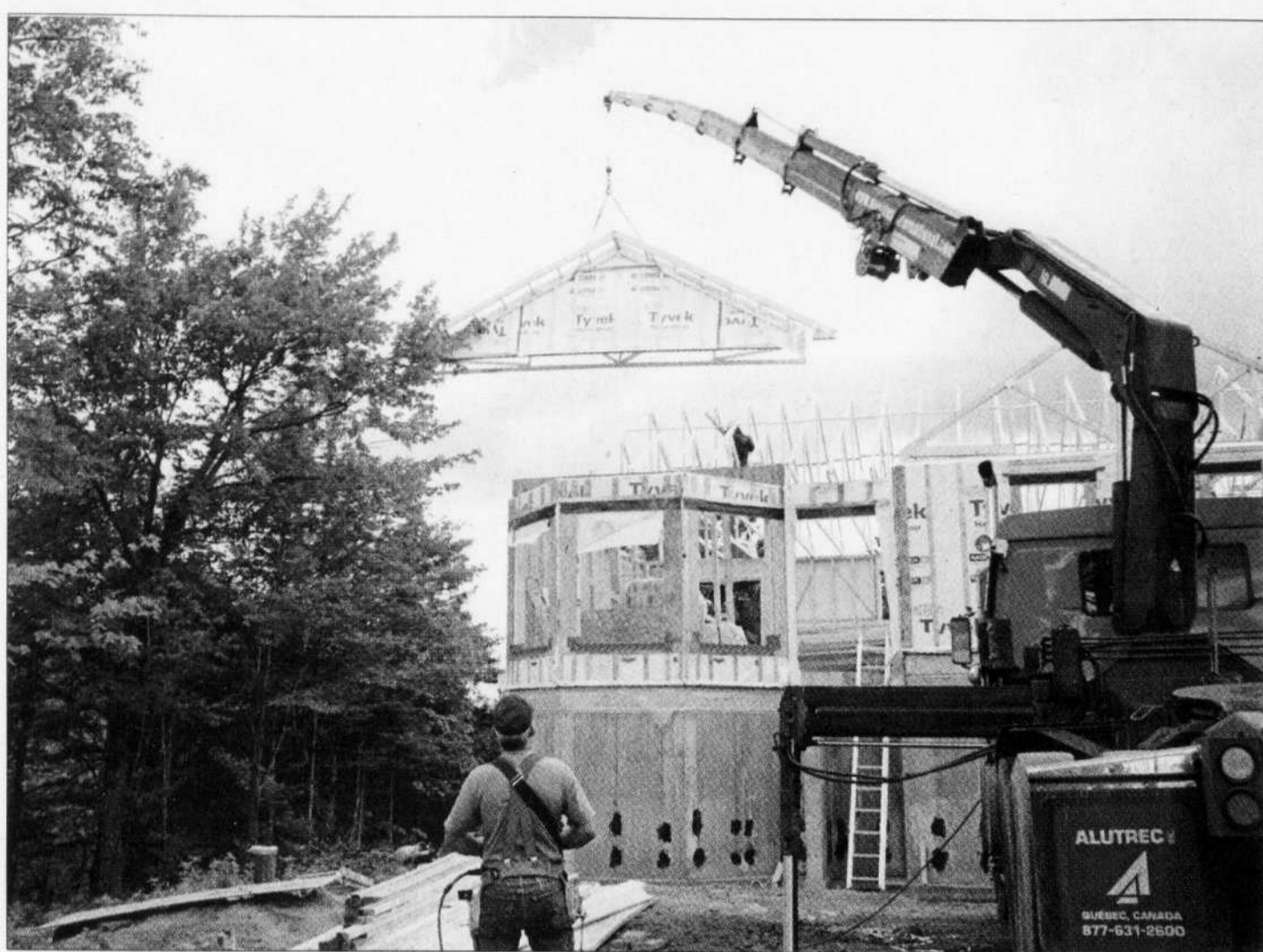
Le montage des chevrons d'une maison usinée. Il existe deux techniques de fabrication des maisons usinées: par modules ou par panneaux.
