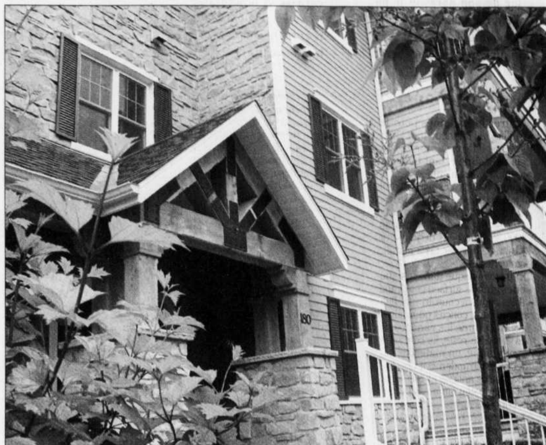
La deuxième phase du Cercle des Cantons consiste en 55 unités comprises dans un immeuble à trois étages de style rustique chic.
