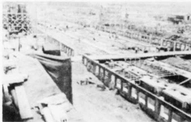
La deuxième usine Shawinigan pendant l'été 1941, lors de la construction des lignes 103 et 104.
