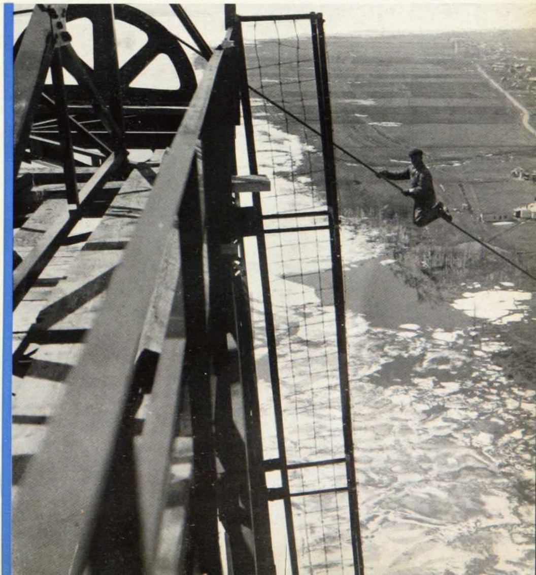
Une des puissantes tours de suspension de la Shawinigan Water and Paper Co., près des Trois-Rivières, photographiée durant sa construction.
