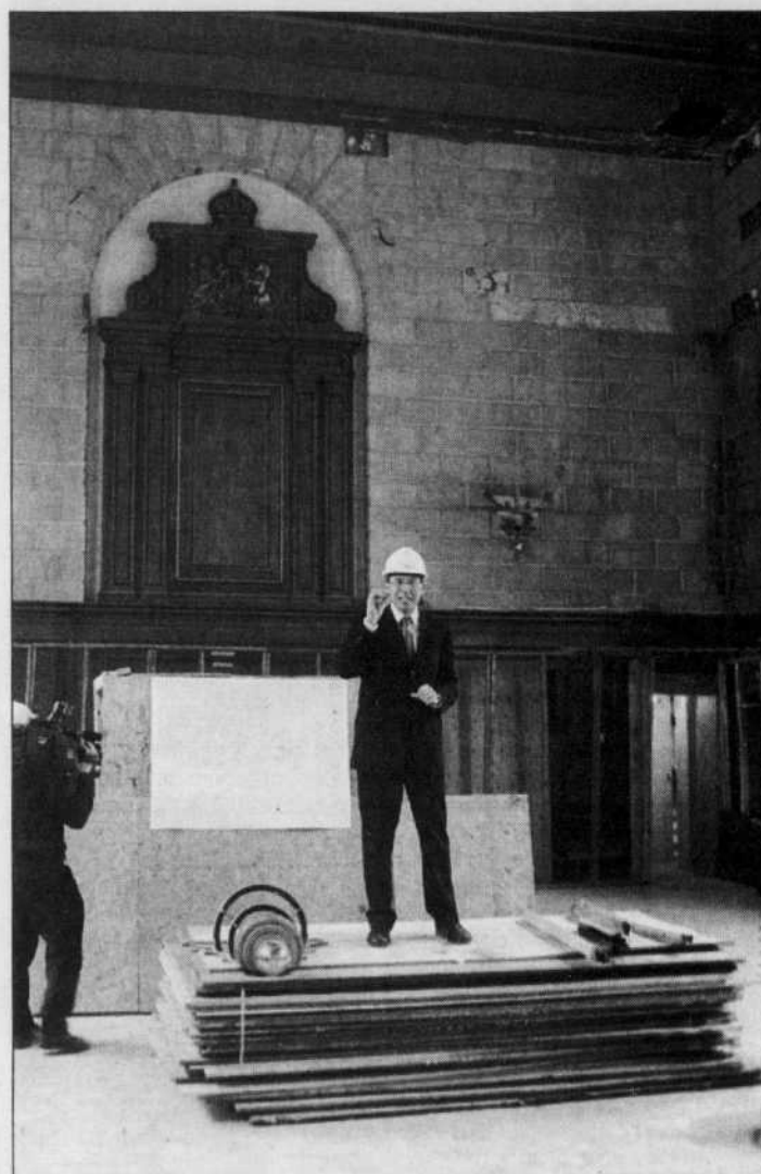
JACQUES GRENIER LE DEVOIR Daniel Gilbert, président de la SIQ, dans la salle Cusson de l'édifice Ernest-Cormier, lors de la visite du chantier, hier.
