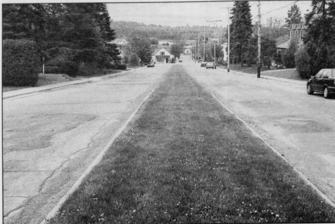
À ce moment-ci, les plans de réfection de la rue Grove annoncent la disparition du terre-plein qui donnait à cette rue l'allure d'un boulevard entre les rues St-André et Alexandra.
