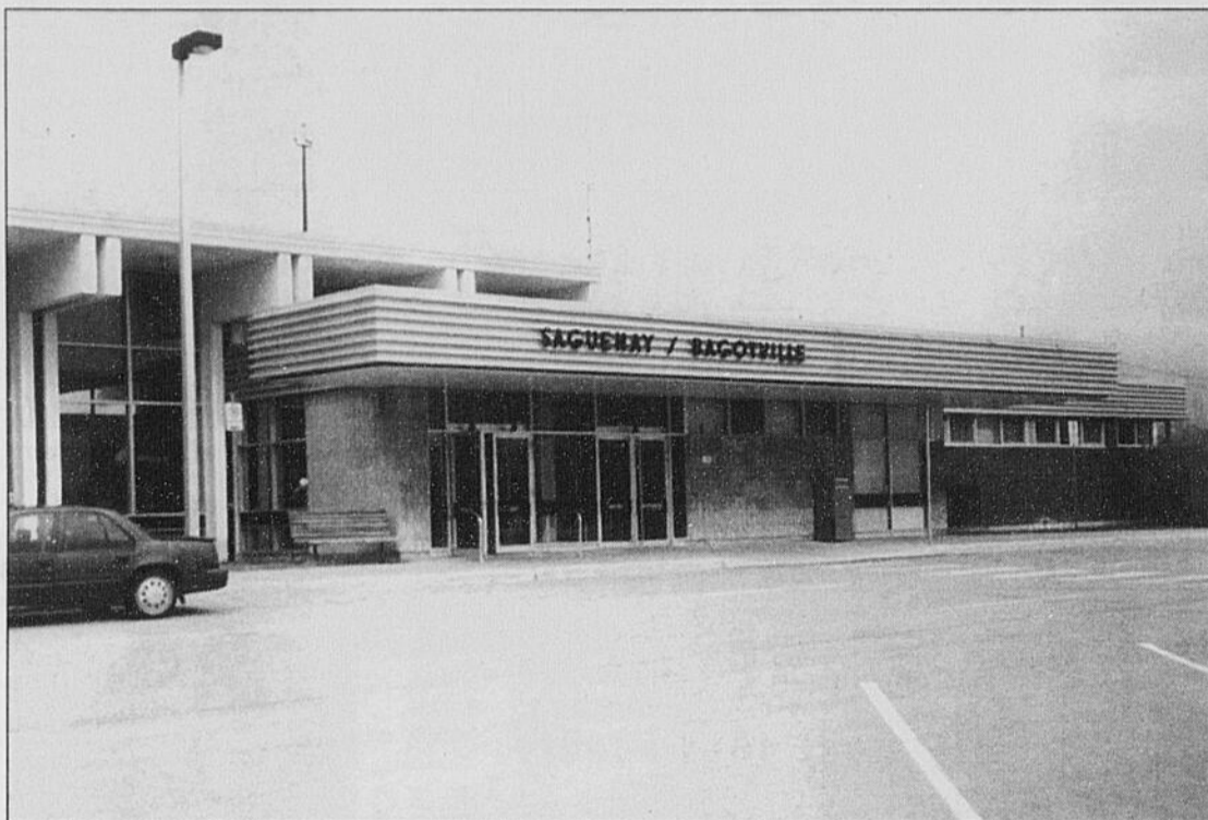
AÉROPORT - L'aérogare civile de Bagotville deviendra sous peu propriété de La Baie pour la modique somme de 1 $. Une bonne transaction selon le comptable Athur Gobeil.
