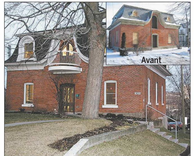
Bâtiment situé au 101, rue Court Arrondissement de Jacques-Cartier Michel Jubinville Conception : Jubinville architectes Réalisation : Construction Guy Sébas inc.
