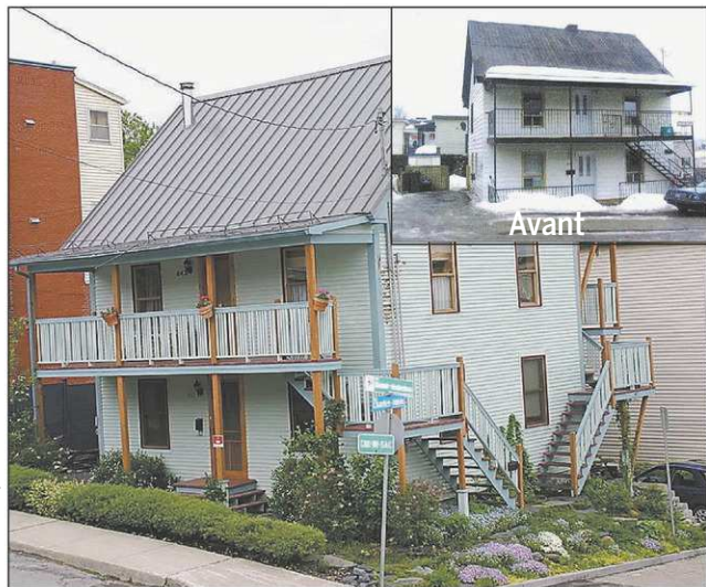
Bâtiment situé au 841-843, rue Saint-Antoine Arrondissement du Mont-Bellevue Hélène Laperrière Conception : Hélène Laperrière Réalisation : Luc Voinson
