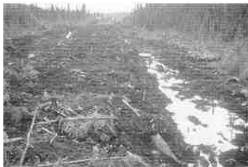
Figure 2. Forme de chemin construite en automne.
