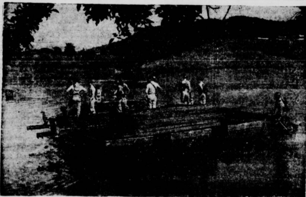
Les membres du corps des ingénieurs de l'armée américaine, dans la zone du canal de Panama, sont à placer une section de pont "sous le feu". Ils établirent un record en installant la travée de 1,070 pieds à travers la rivière en une heure et quarante minutes.
