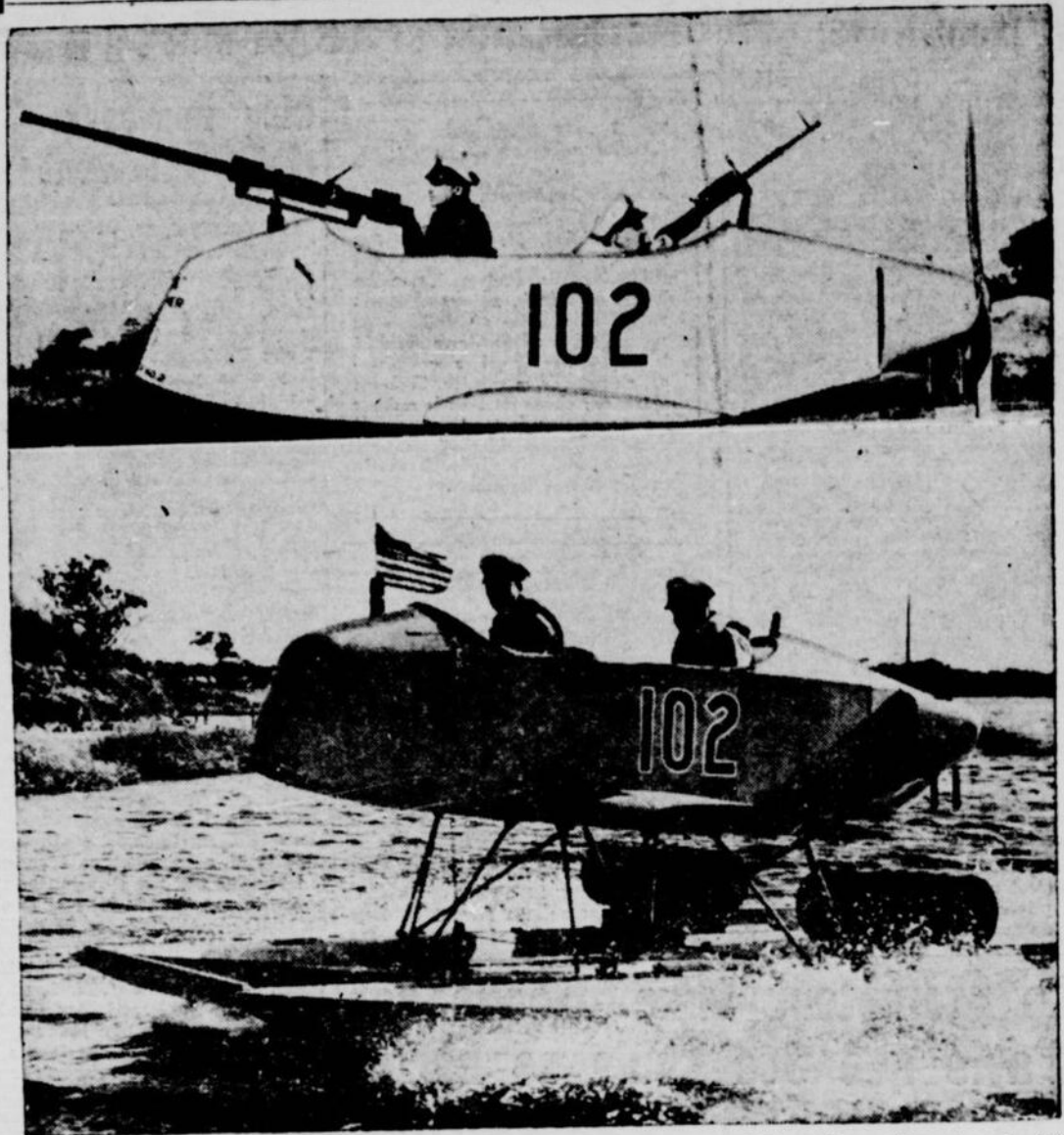
La dernière arme pour combattre les sous-marins est le chasseur appelé "Wave Hopper", qui atteint 50 milles à l'heure. Il porte des grenades sous-marines qui peuvent être remplacées par des torpilles. Son inventeur est Antonia Gazda qui a aussi inventé le canon Oberlikon, à tir rapide.
