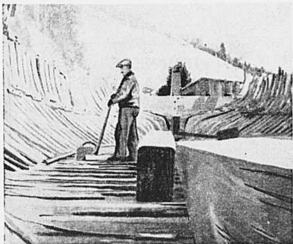
Ci-dessus. C'est généralement l'hiver que l'on entreprend la construction de goélettes. Quelques ouvriers posent ici la quille d'un caboteur qui parcourra les eaux du Saint-Laurent et du Saguenay. — Ci-dessous. Projetée avec violence contre le quai de Ste-Anne-des-Monts, il y a quelques années, cette goélette de fer n'a pu être renflouée que par le déchargement de sa cargaison constituée de bois de construction.
