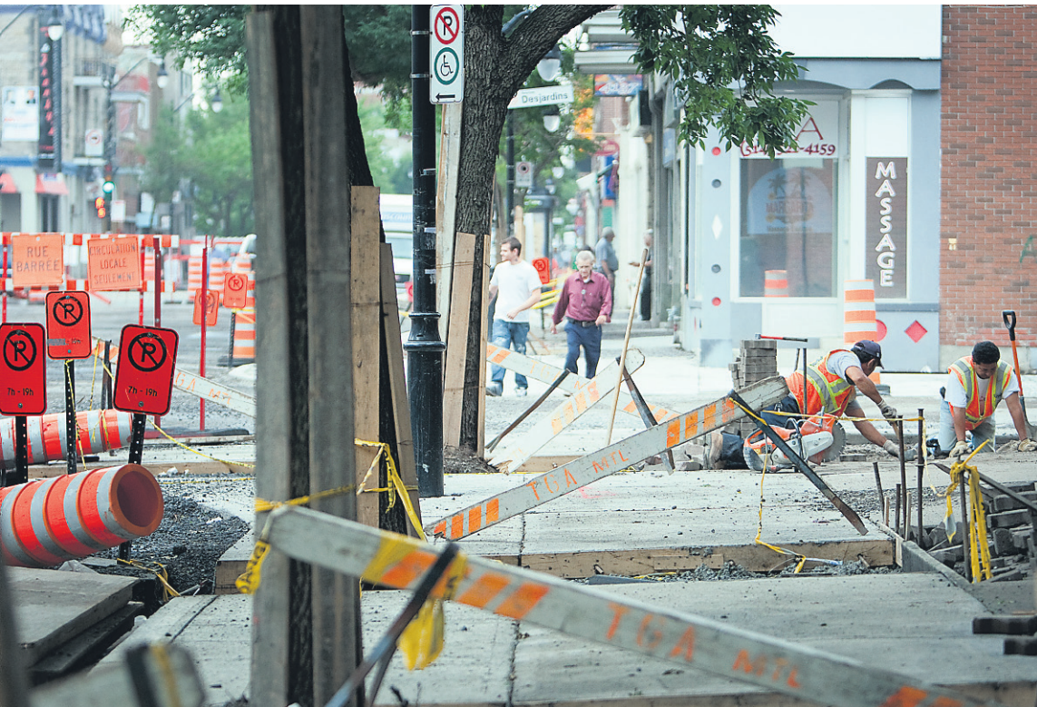
Des camions et des dizaines de travailleurs coiffés de casques blancs s’activent dans la rue Sainte-Catherine Est. Des planches de bois couchées au fond de tranchées de gravier font office de trottoirs. Les rares piétons zigzaguent à travers le dédale de véhicules, de trous et de panneaux orange.
