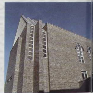
Collège St-Maurice, St-Hyacinthe 08-Mélange Adobe Jodoin Lamarre Pratte et Associés, architecte Maçon: Rainville & Frères inc.
