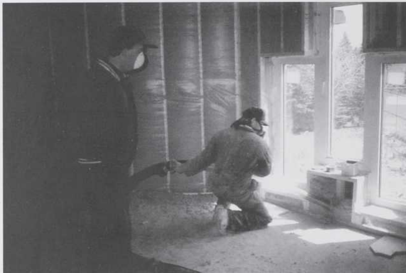
Mise en place de fibre cellulosique. Photo APCHQ.
