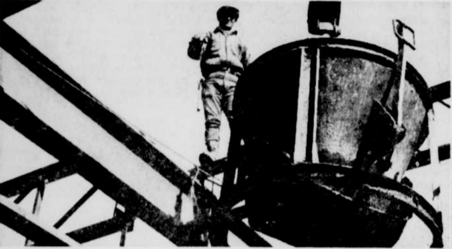
LA CONSTRUCTION du nouveau centre technique de la Chemcell à Drummondville, au coût de $1,000,000 sera terminée cet automne.
