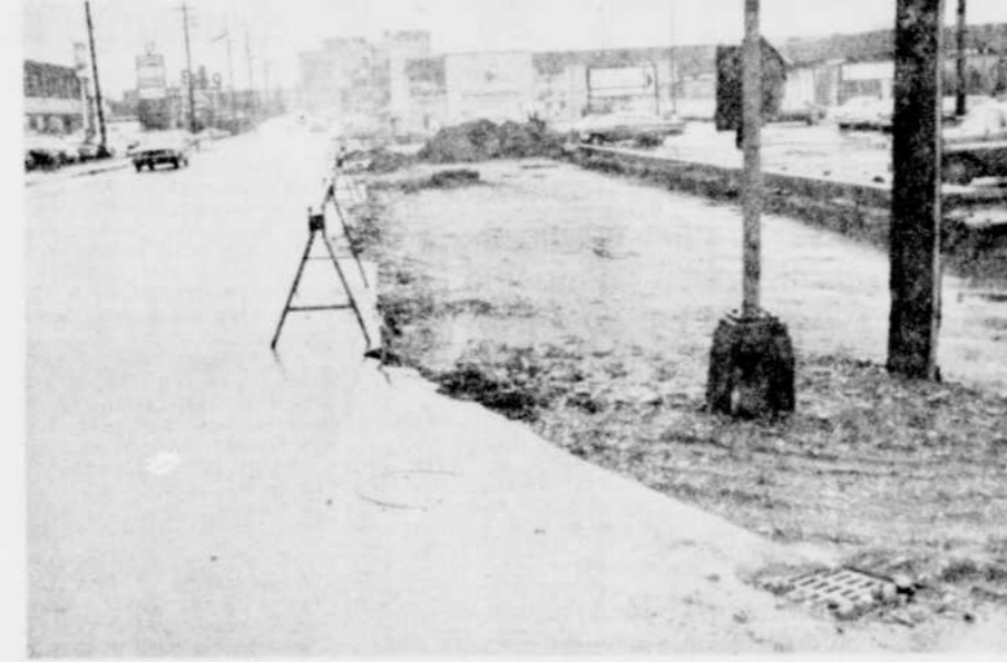
RUE BELVEDERE SUD. — La voirie de la cité de Sherbrooke est à procéder actuellement à l'élargissement de la rue Belvédère sud. (Photo La Tribune, par Studio Breton)
