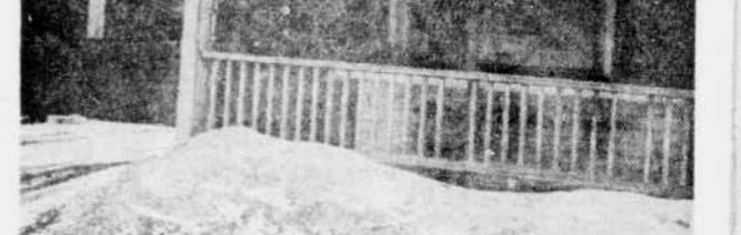
ENFIN DEMOLIE — La maison située au 35 rue Perreault tombera sous le pic des démolisseurs d'ici quelques jours, à la demande des autorités de la ville. Un groupe de démolisseurs l'ont dégarnie, hier après-midi, des "trésors d'antiquités" qu'elle couvrait dans son sein, comme en fait foi cette photo montrant un amoncellement de "souvenirs" accumulés sur la galerie avant. Le conseil a demandé la démolition immédiate de cette bâtisse à la suite de l'expiration du délai fixé par la loi. (Photo La Tribune, par Marc Lestage)
