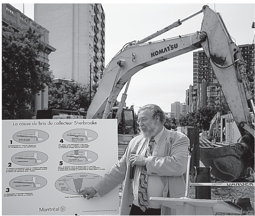
Yves Provost, du Service des infrastructures, transport et environnement de la Ville, explique les travaux à effectuer rue Sherbrooke.
