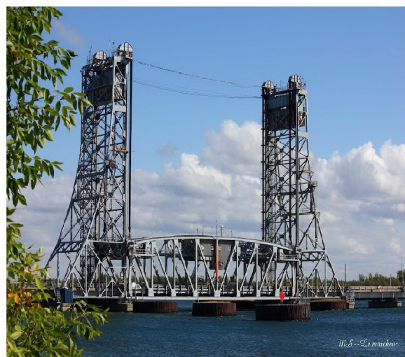
Pont levant de Valleyfield
