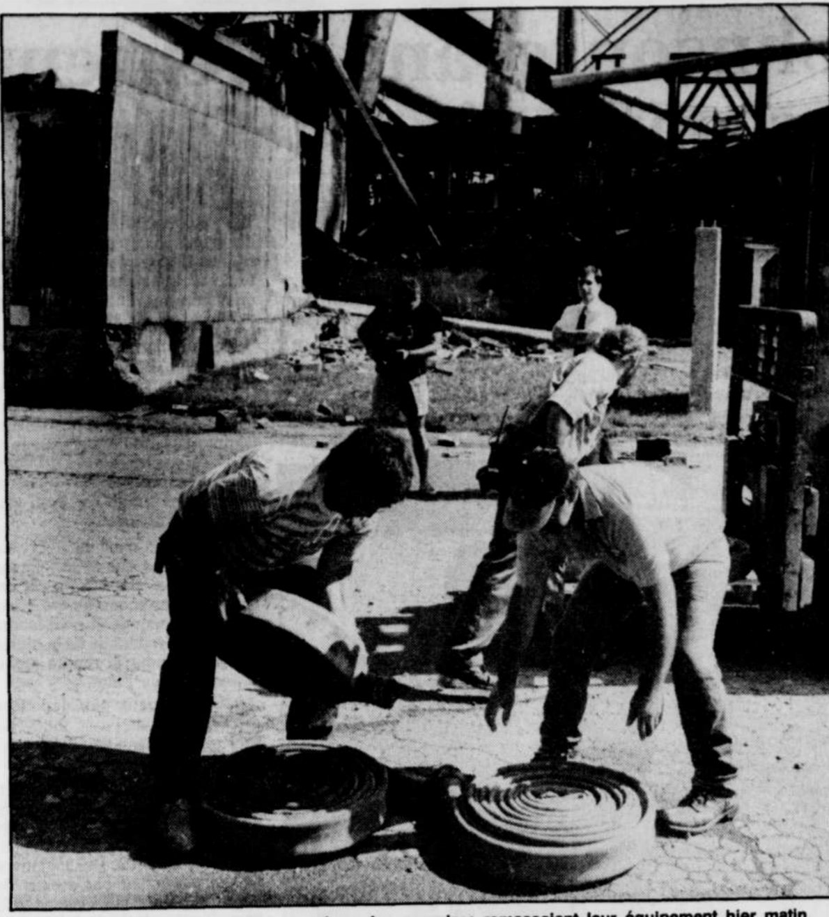
Devant l'usine Garant, en partie en ruines, les pompiers ramassaient leur équipement hier matin.
