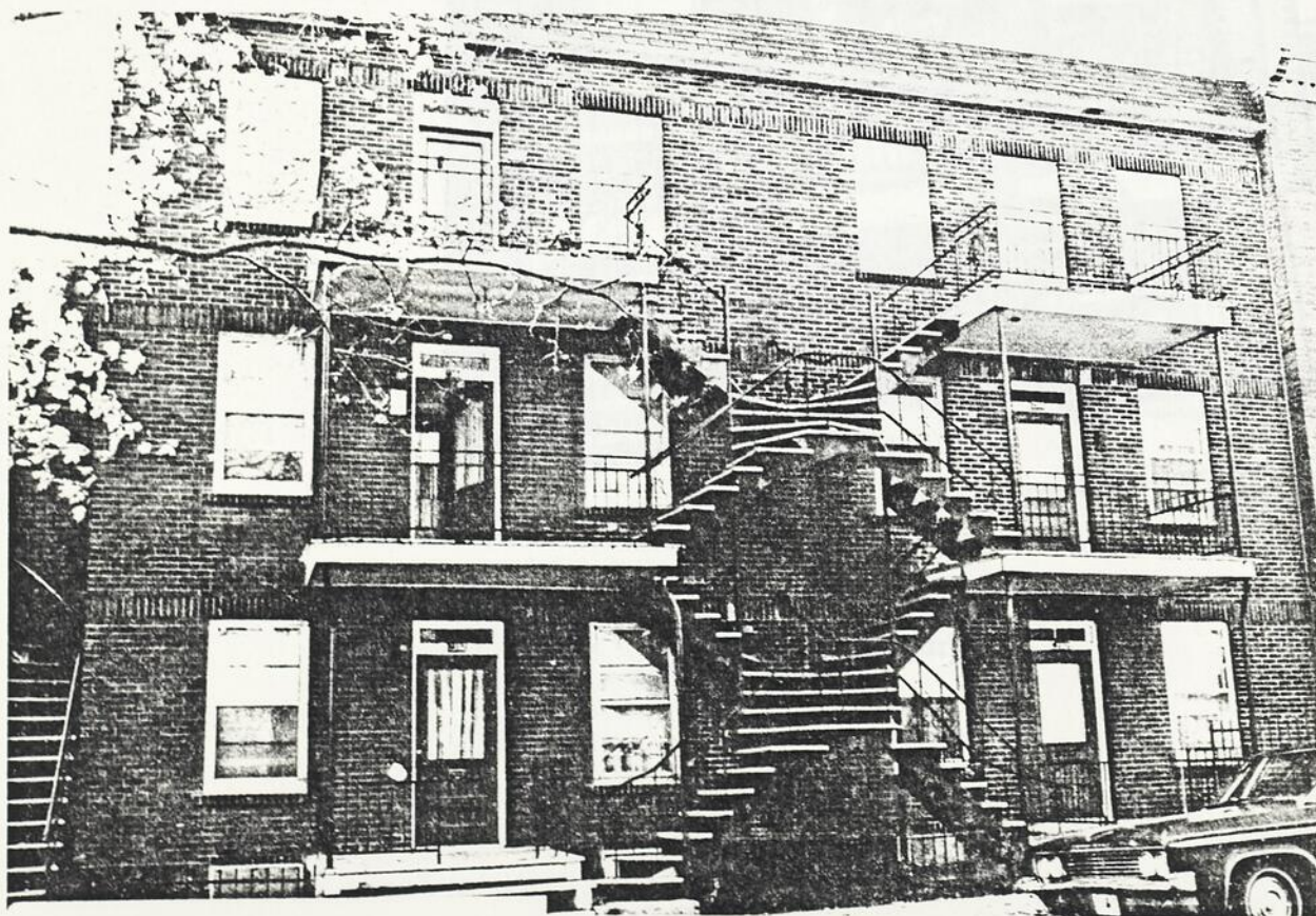
Fig. 80 Escalier extérieur menant au troisième étage, 2302-12 Moreau.
