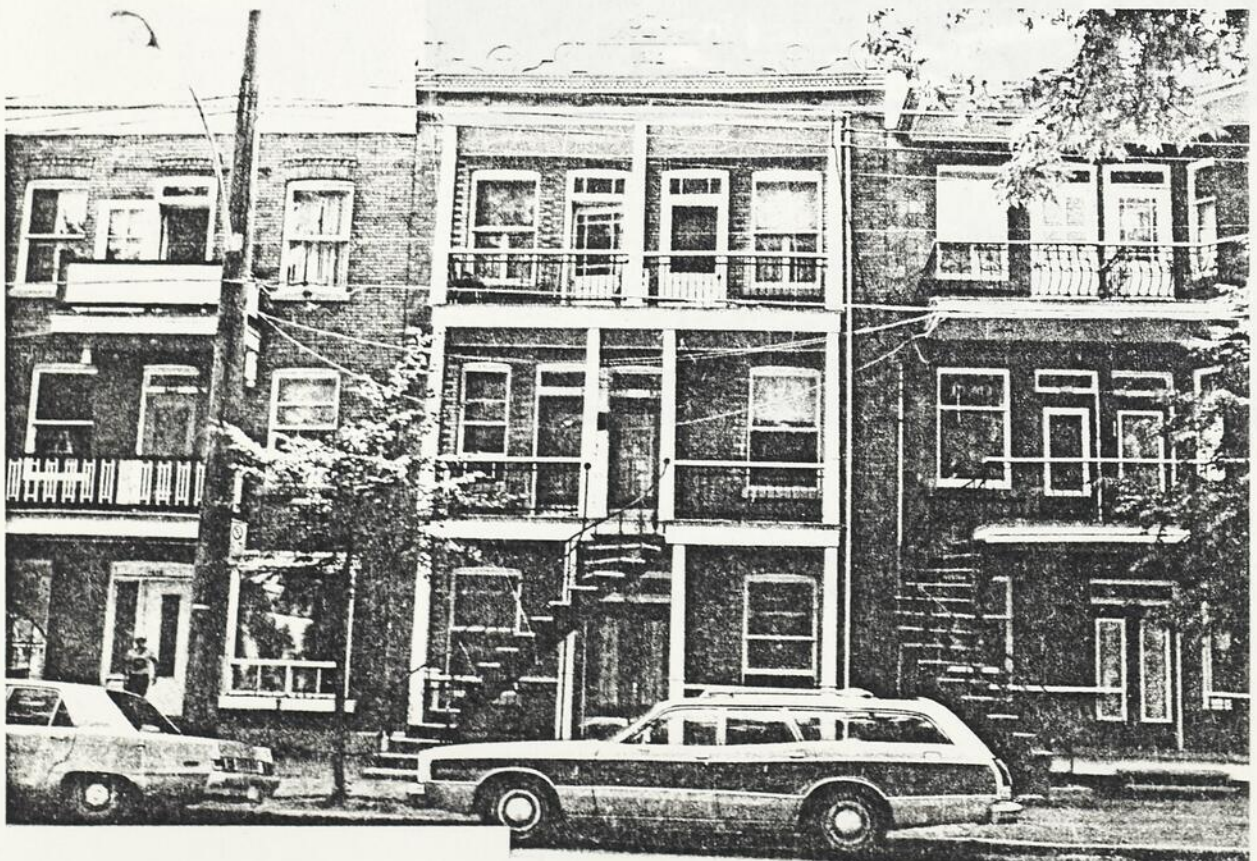
Fig. 90 Modification aux ouvertures, 3624-42 Adam.
