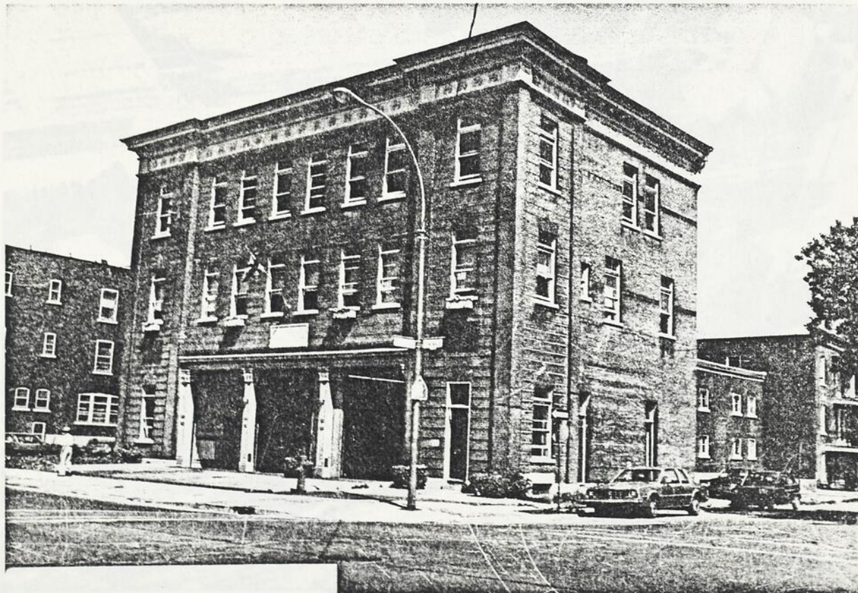
Fig. 135 Poste d'incendie 4200 Ontario est.
