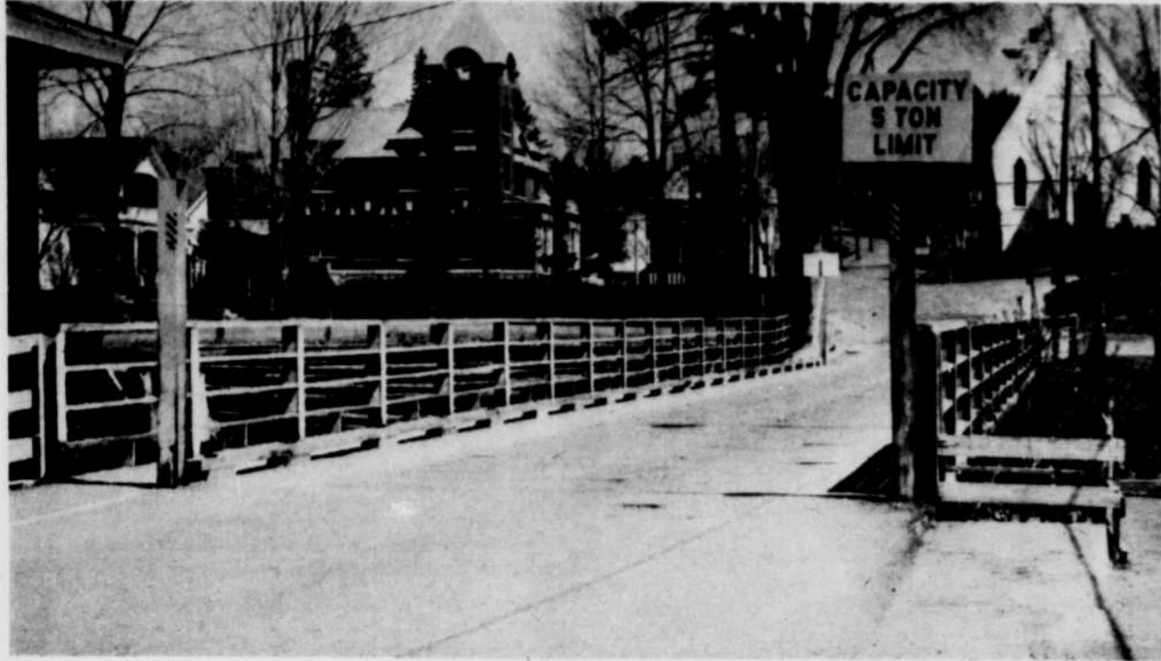
Le pont Katham ainsi nommé en l'honneur du premier maire de Rock Island.
