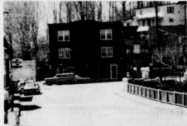
Le pont du boulevard Notre-Dame a déjà été un pont couvert mais a été rénové par la suite.
