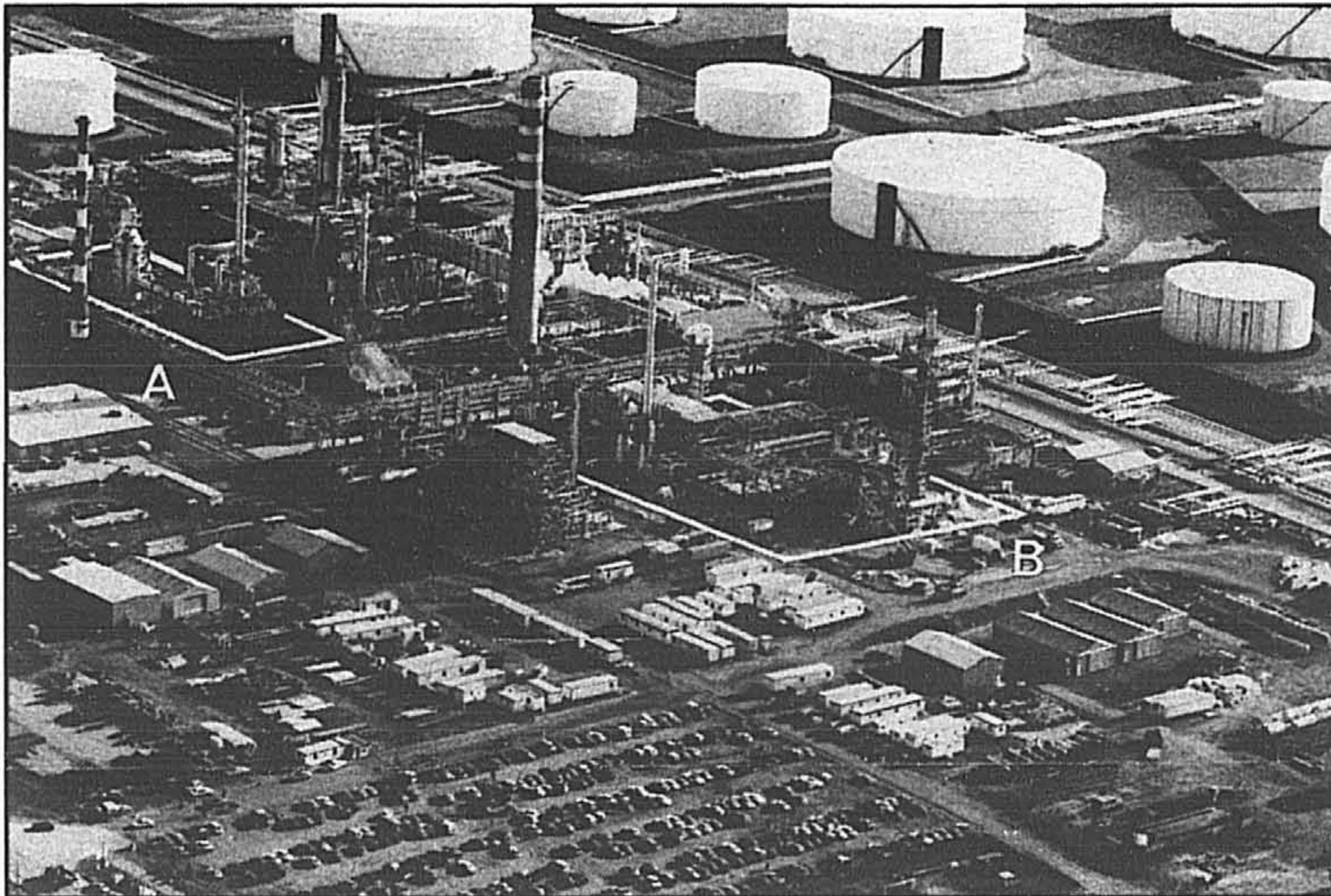
La raffinerie de Saint-Romuald, après les travaux de modernisation réalisés grâce à des investissements de 100 millions de dollars. Nous voyons en A et B les nouvelles unités de raffinage.
