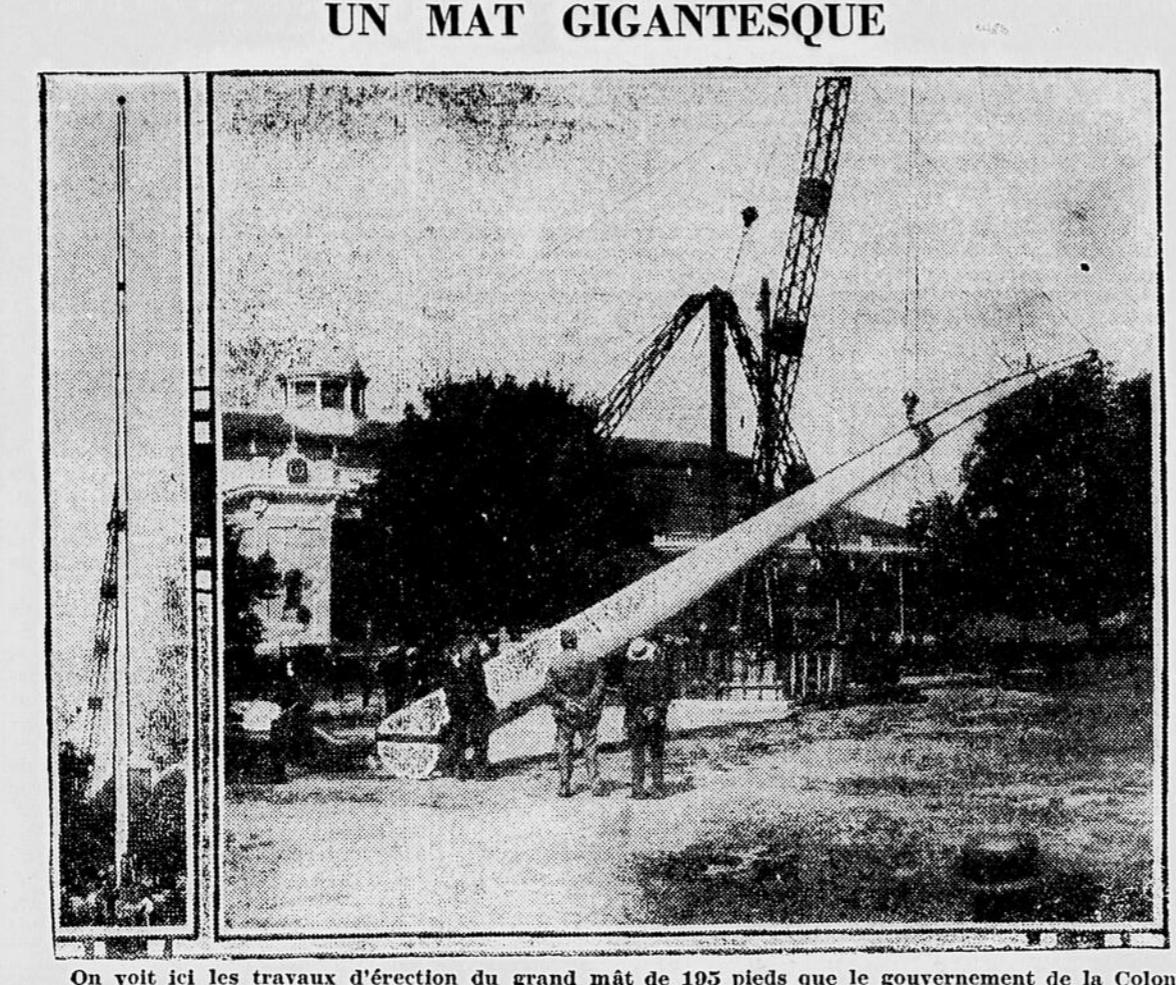
On voit ici les travaux d'érection du grand mâât de 195 pieds que le gouvernement de la Colombie Anglaise vient d'offrir à l'Exposition de Toronto. Ce mâât est érigé au sud du pavillon Horticole. C'est probablement le plus haut mâât du monde. Il fut transporté à Toronto, par mer, via le Canal de Panama. A gauche on voit le mâât, tel qu'il apparaît érigé. Il fallut pour l'ériger une grue de 77 pieds de long.
