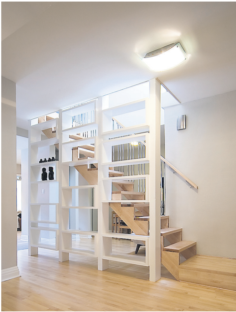
PHOTOS FOURNIES PAR LES ATELIERS L. MCCOMBER Des étagères font office de garde-corps dans cette cage d'escalier.
