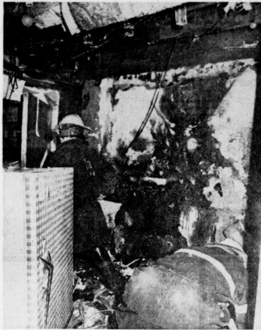
Les flammes faisaient rage dans le mur et avaient déjà gagné le plafond d'un appartement de la rue Saint-Vallier ouest, hier soir, quand les pompiers en sont venus à bout.
