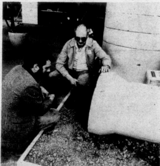
Voir de près des infrastructures qui ne sentent pas!
