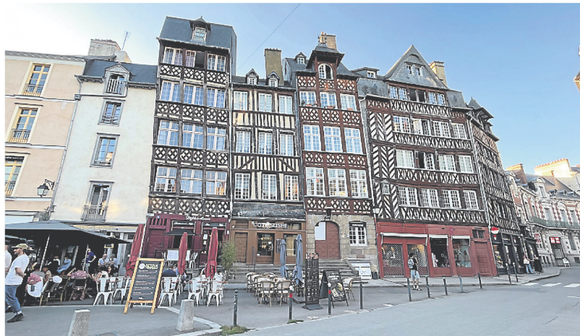
À Rennes, on construisait autrefois les maisons en bois, faute de pierres disponibles localement.
