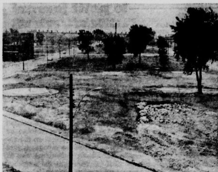
Sur les terrains du Village-aux-Oies, le stade de l'Expo remplacera des maisons vétustes.
