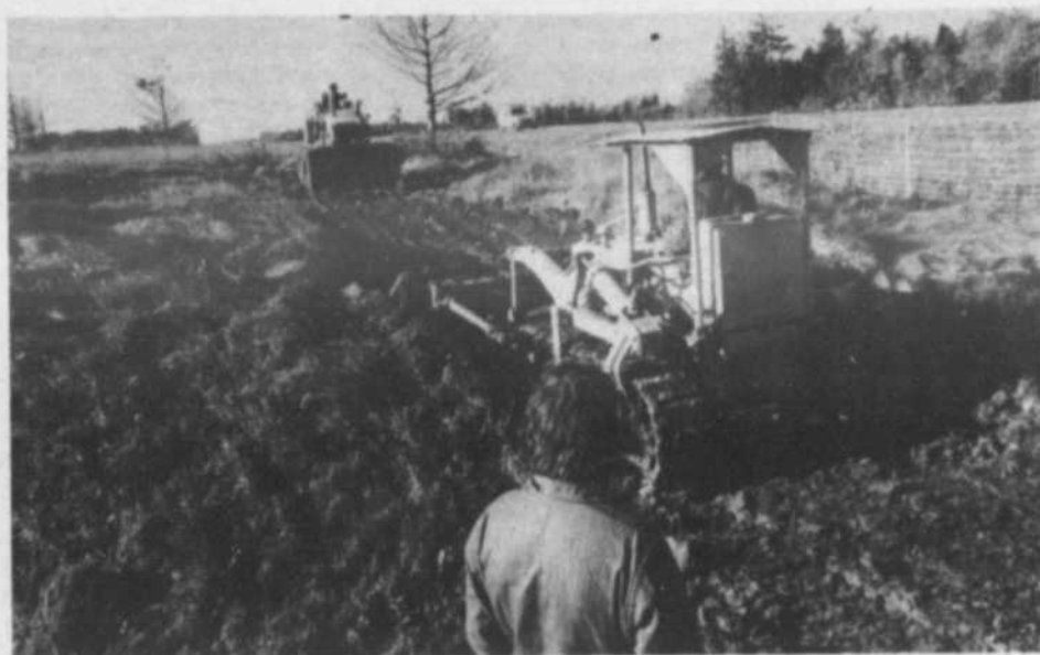
La machinerie lourde a été affectée à la construction de la nouvelle piste. Robert Hardy, secrétaire du Club régional, surveille attentivement les travaux. (photos Pierre Lecours)
