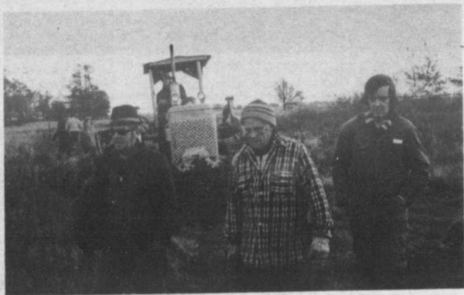
Le président du Club de motoneige régional de Repentigny, M. Gérard Quintal, et plusieurs volontaires ont débuté les travaux de la nouvelle piste de motoneige.
