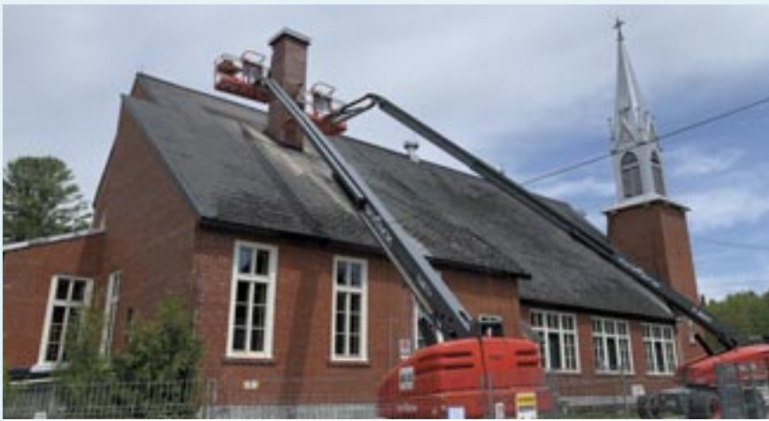
Travaux de réfection de la toiture.
