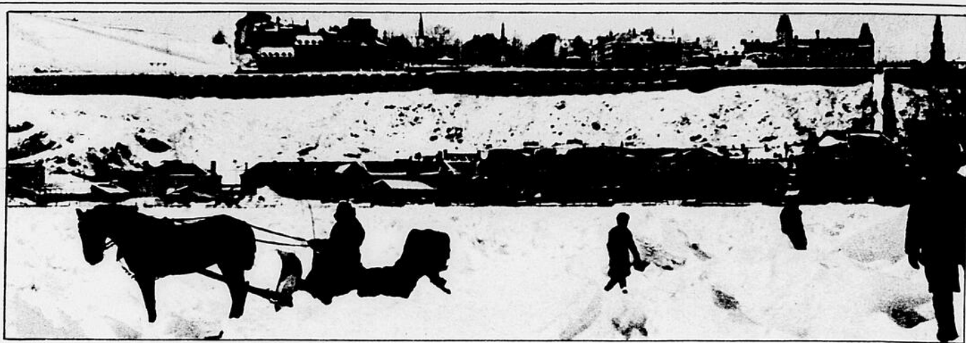
Traineau circulant entre les bourguignons sur un chemin praticable du pont de glace.
