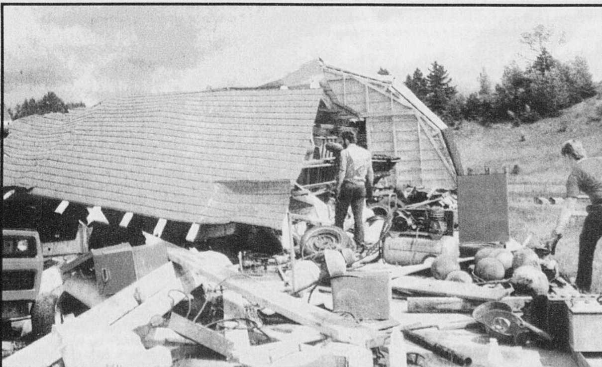
Un vaste bâtiment sur la propriété de M. Émile Lemire a été soufflé par le vent.
