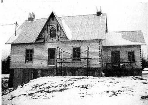
« Cette subvention alléchante nous a incités à se construire à Frampton »
