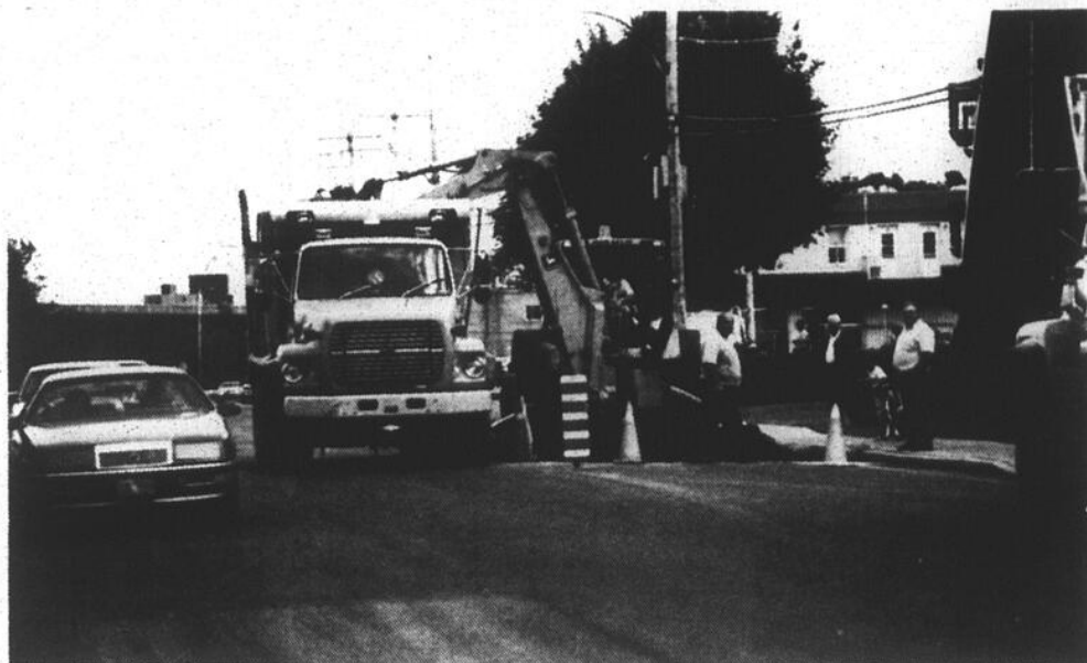
Une fuite du réseau d'aqueduc a obligé les cols bleus à creuser jeudi sur la rue Champlain qui venait à peine d'être pavée à neuf. (photo Jacques PAUL)
