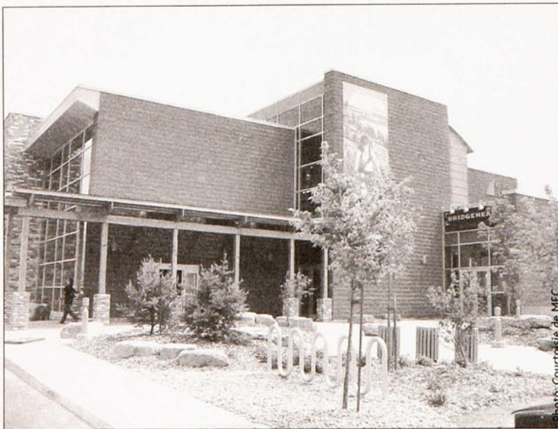
Le système de chauffage géothermique de la coopérative de plein air Mountain Equipment Coop, à Montréal, fonctionne avec des pompes reliées à 12 puits de 175 mètres de profondeur pour en extraire la chaleur.
