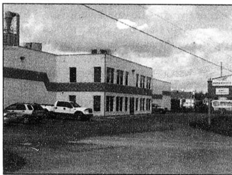
Une partie des installations des entreprises Inter-Bois et Inter-Sec ainsi que Structure de Beauce sur la rue Industrielle.
