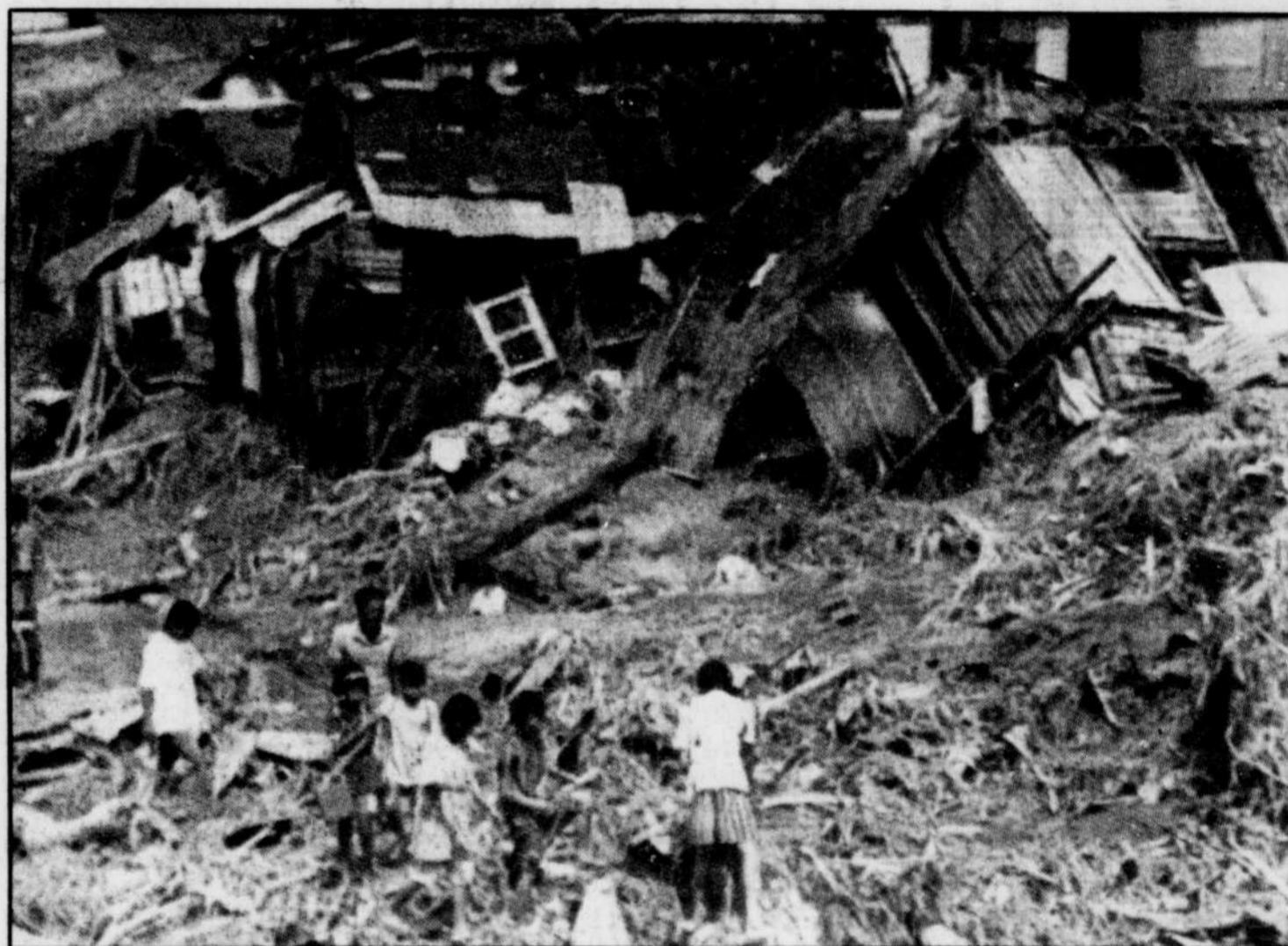
Des survivants se fraient un passage à travers les débris à Ormoc, la ville qui a été la plus touchée par le typhon «Thelma». C
