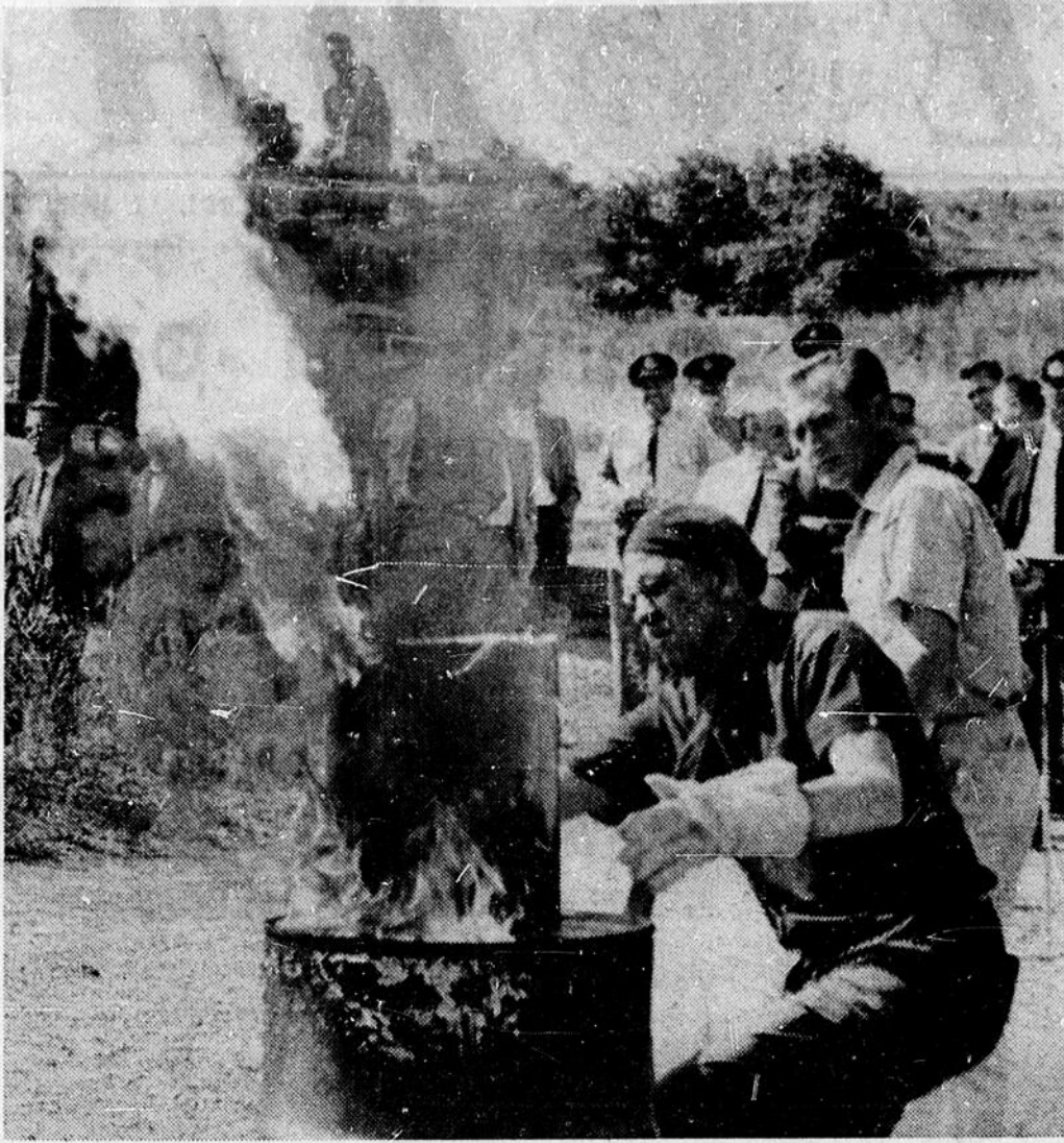
M. Nemeth démontrant que seul l'extérieur des réservoirs peut être atteint par les flammes et que nulle explosion ne pourra briser le contenant. (Photo Champlain Marciel)
