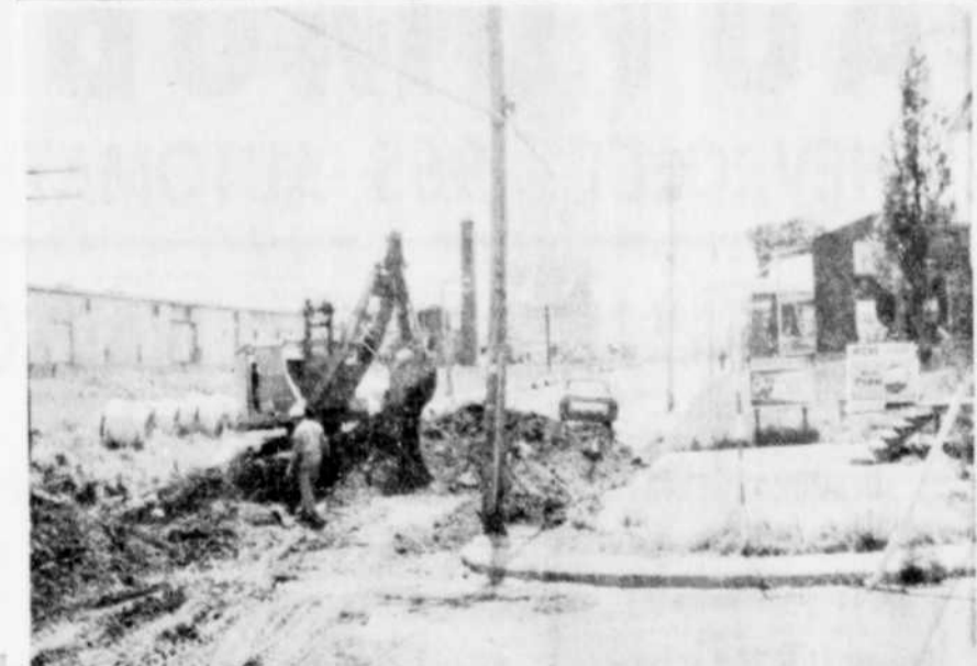
CIRCULATION BLOQUEE. — Des employés de la Voirie municipale de Victoriaville sont présentement affectés aux travaux de l'installation d'aqueduc et d'égouts sur le boulevard Gamache. On doit faire une installation spéciale afin d'accommoder les résidents d'un secteur que l'on vient d'annexer à la ville de Victoriaville. (Photo La Tribune, par Marcel Rivard)
