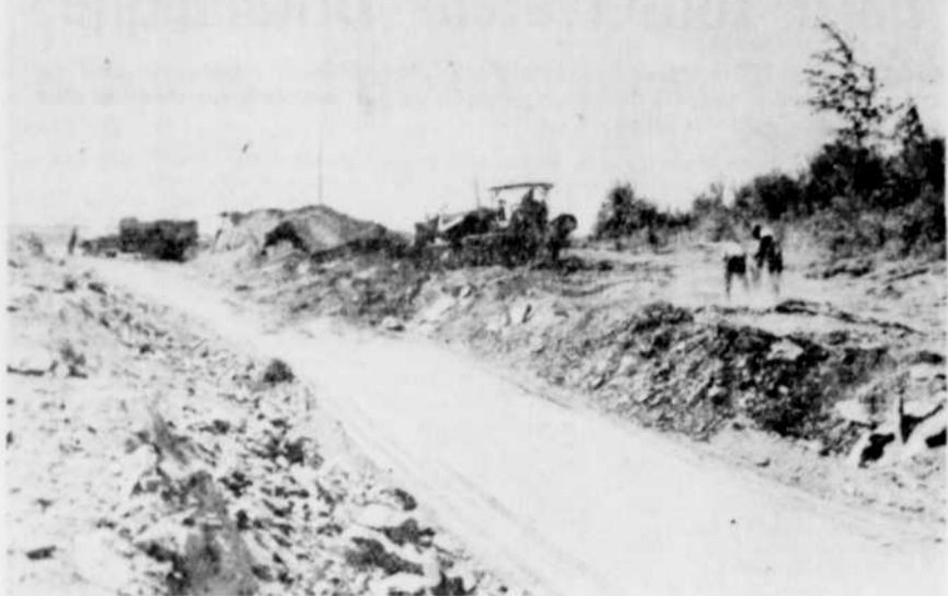
EN CONSTRUCTION. — Les travaux de reconstruction d'une autre section de la route Ste-Edwidge-Coaticook avancent rapidement, malgré les conditions dans lesquelles le conducteur doit poursuivre. Sur cette photo, les machineries s'attaquent à la terre meuble, pendant que des employés se préparent pour dynamiter le roc, qui se retrouve sur la majeure partie du parcours.
