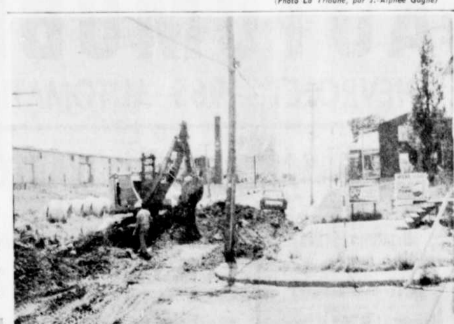
CIRCULATION BLOQUEE. — Des employés de la Voirie municipale de Victoriaville sont présentement affectés aux travaux de l'installation d'aqueduc et d'égouts sur le boulevard Gamache. On doit faire une installation spéciale afin d'accommoder les résidents d'un secteur que l'on vient d'annexer à la ville de Victoriaville.
