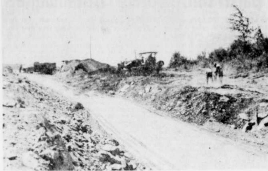
EN CONSTRUCTION — Les travaux de reconstruction d'une autre section de la route Ste-Edwidge-Coaticook avancent rapidement, malgré les conditions dans lesquelles le conducteur doit les poursuivre. Sur cette photo, les machineries s'attaquent à la terre meuble, pendant que des employés se préparent pour dynamiter le roc, qui se retrouve sur la majeure partie du parcours. (Photo Ross, Coaticook)
