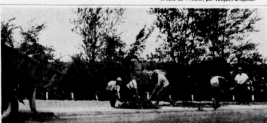
OPERATION TOURBAGE. — Les travaux de redressement des courbes du moulin sont depuis longtemps terminés. Toutefois, il reste encore quelques travaux secondaires. Ainsi, ci-haut, on s'affaire au revêtement de tourbes du bord du nouveau trottoir. La tourbe servira à épauler le trottoir tout en donnant plus d'apparence. D'ici peu, on doit peindre les lignes blanches sur le macadam. Les repères ont déjà été mis en place. On tracera trois voies, dont deux serviront à la circulation dirigée vers Sherbrooke. (Photo La Tribune, par André Therrien)
