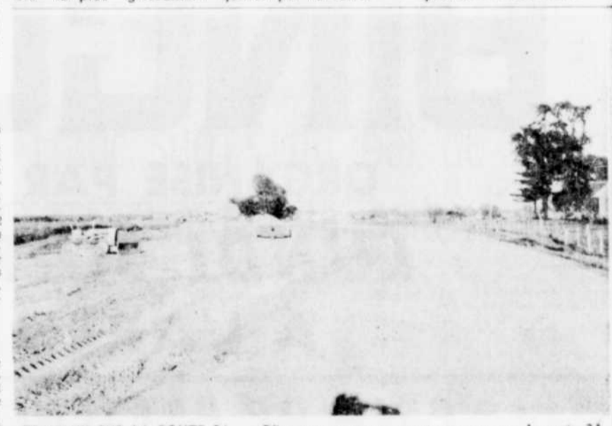
TRAVAUX SUR LA ROUTE 34. — D'importants travaux sont en cours sur la route 34 de Victoriaville vers la transcanadienne. Comme l'avait annoncé l'honorable Morissette, il semble bien que la partie située dans notre comté sera en totalité faite cette année. Pour la population ce sera un excellent débouché pour la route neuve.
