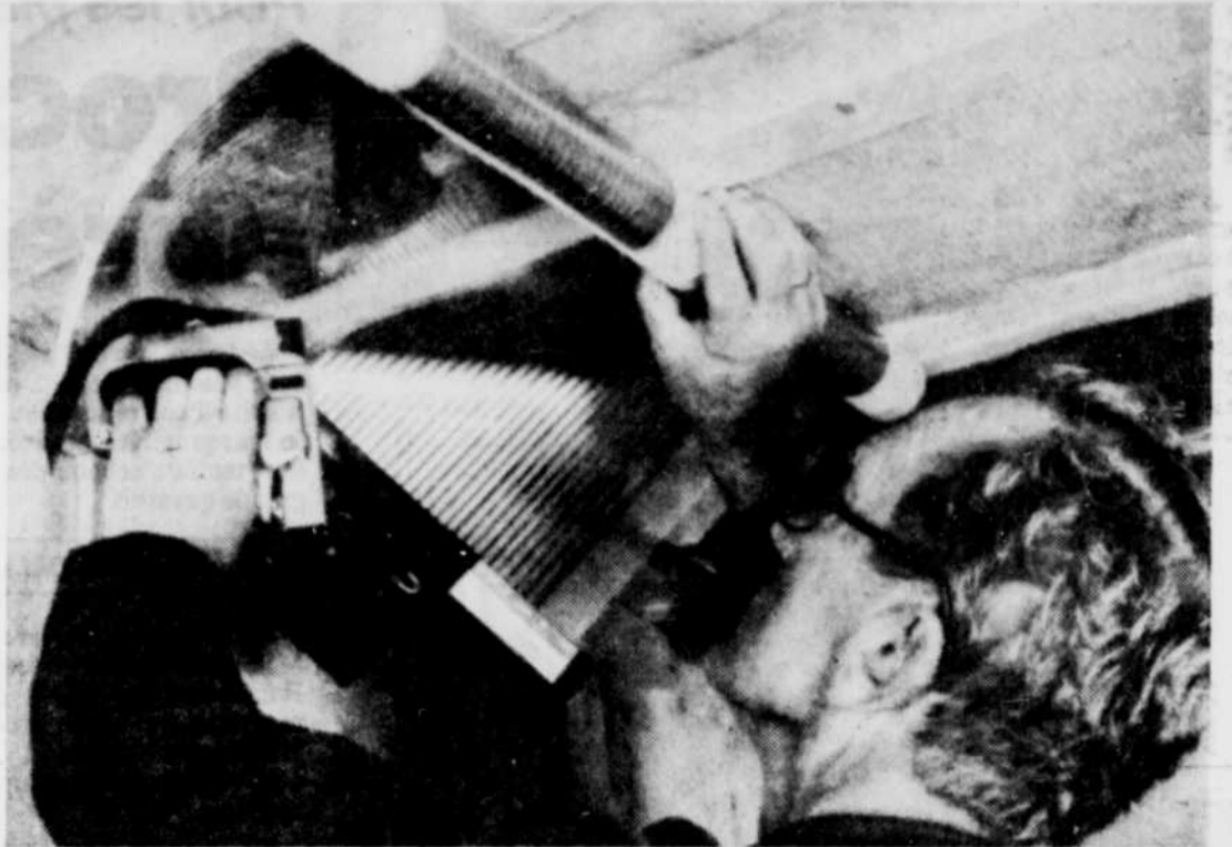
Installer la pellicule chauffante au plafond sera un jeu d'enfant pour l'entrepreneur-électricien. Une brocheuse lui sera indispensable.
