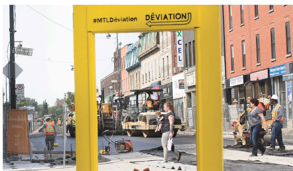
L'organisme Art souterrain a été mandaté pour monter l'exposition Déviaton , qui prend racine dans des locaux vacants et sur le mobilier du chantier de la rue Notre-Dame Ouest.
