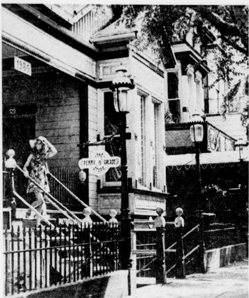
Sur Union Street, de vieilles demeures devenues boutiques
