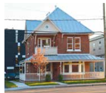
Maison Robitaille, avant et après sa restauration
